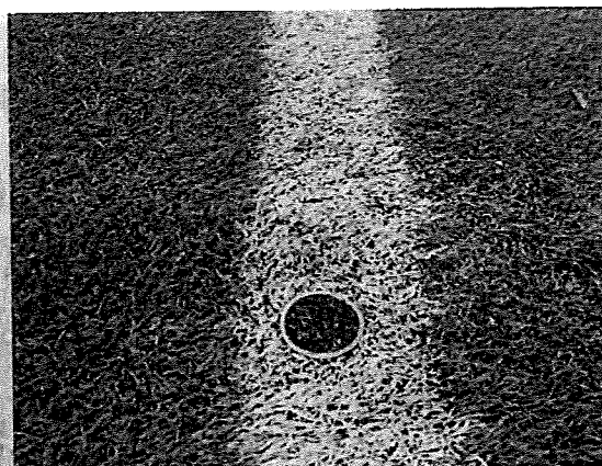
IJzeren kokers in de belijning
