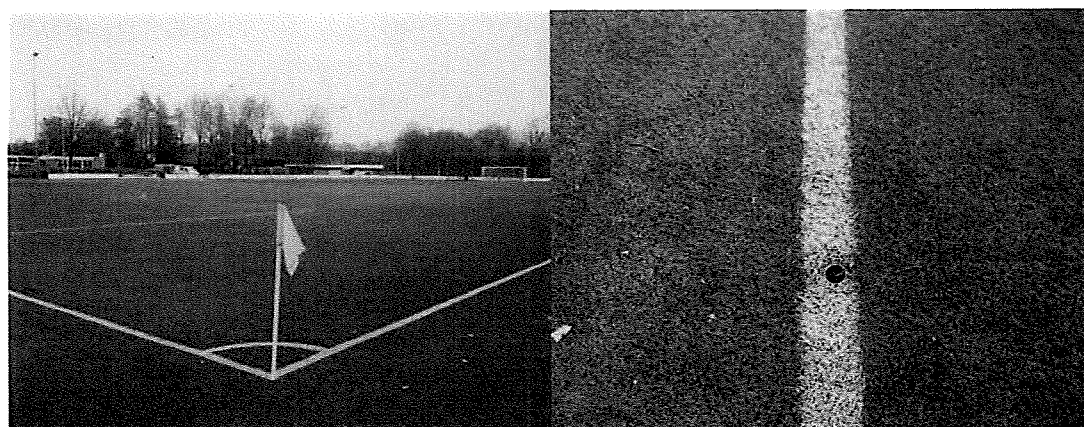
IJzeren kokers in de belijning
